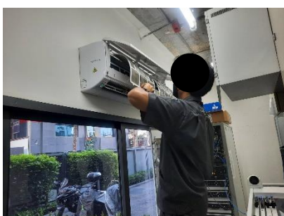
รูปที่ 2-26 ล้างเครื่องปรับอากาศและล้างฟิลเตอร์พื้นที่ส่วนกลาง
